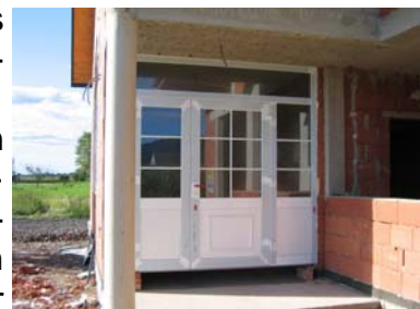
Die Eingangstür wurde schon montiert
