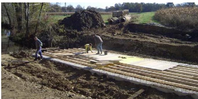
Der Plattendurchlass beim Hochwasserschutzdamm wird errichtet
