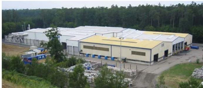
Nach 15 Monaten Bauzeit wurde die erste dem neu definierten Stand der Technik entsprechende Mechanisch-Biologische-Abfallbehandlungsanlage in Österreich am Standort der .A.S.A. Abfallservice Halbenrain GmbH fertiggestellt. Die Anlage befindet sich bereits im Probetrieb und wird jährlich 70.000 Tonnen Abfälle zu deponiefähigem Material oder zu Brennstoffen verarbeiten und Wertstoffe rückgewinnen. Die Investition beträgt 11 Mio €.
