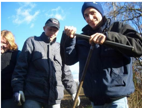
Löcher für die Rohrsteher werden vorbereitet
