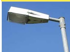
Kofferlampe 80 oder 125 Watt mit Vorschaltgerät
