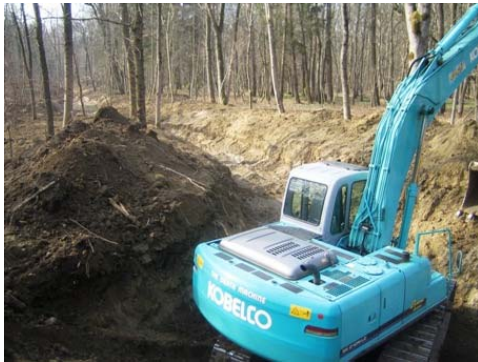
Baggereinsatz beim Trummerbach
