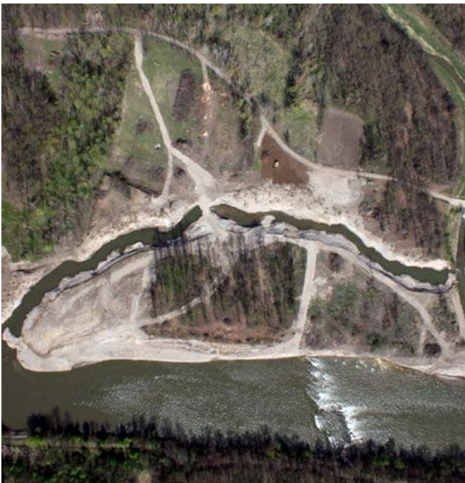
Die Aufweitung Gosdorf von Oben
